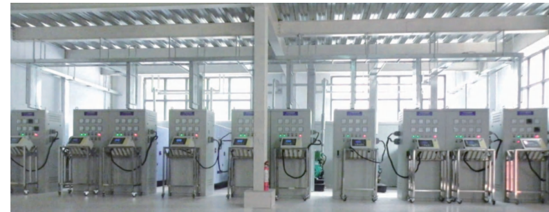
Prototype Testing Room / 发电机组真机试验室
